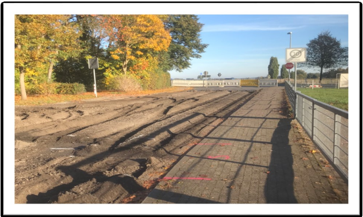
Zu Beginn der Baumaßnahme in der Posener Straße
