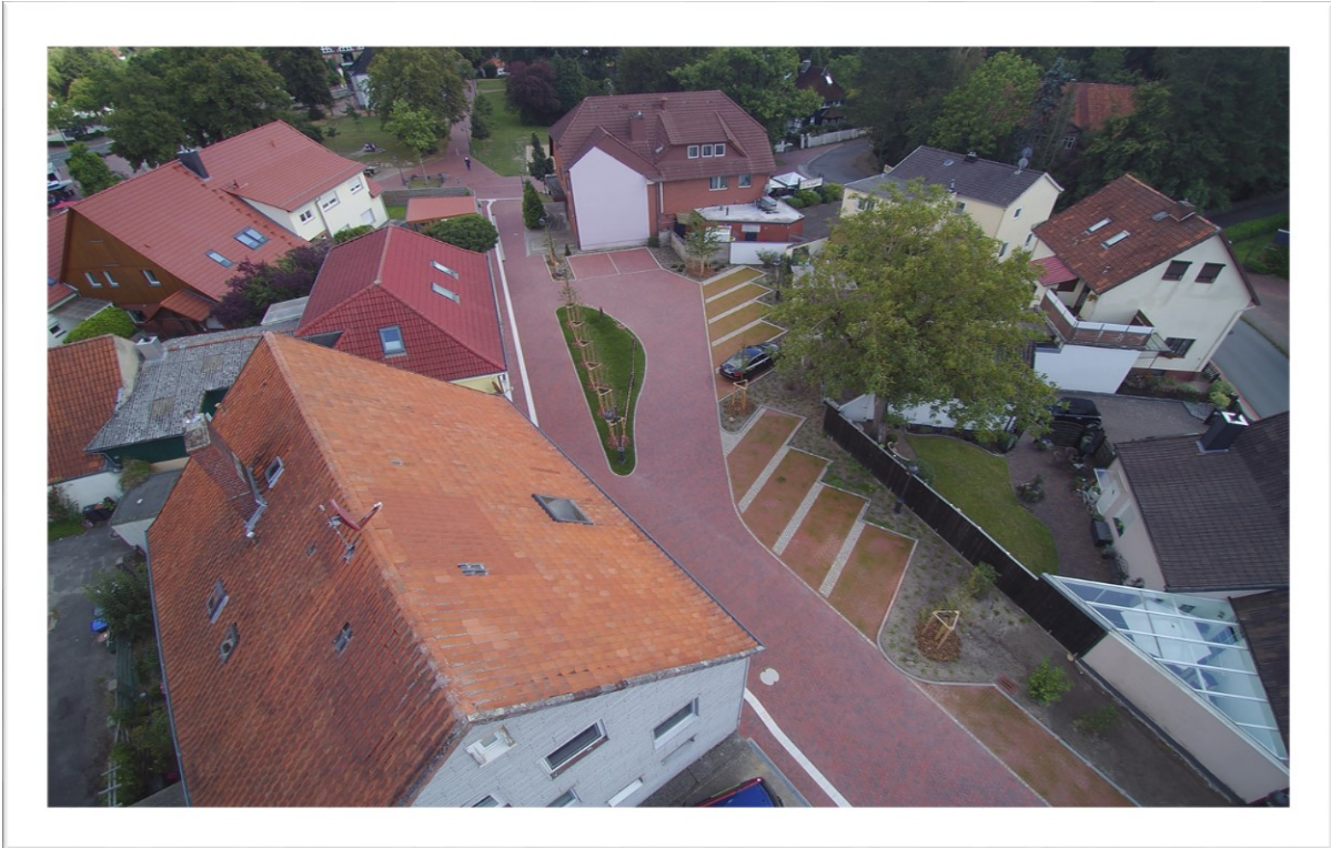
Nach der Fertigstellung der Kirchgasse
