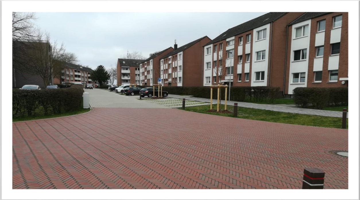
Nach der Fertigstellung der Danziger Straße (südlicher Abschnitt)
