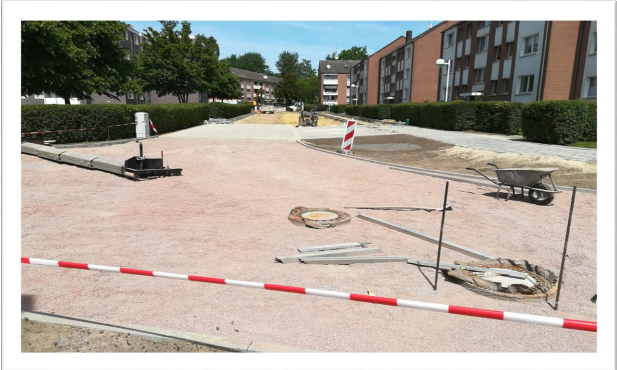
Während der Baumaßnahme in der Danziger Straße
