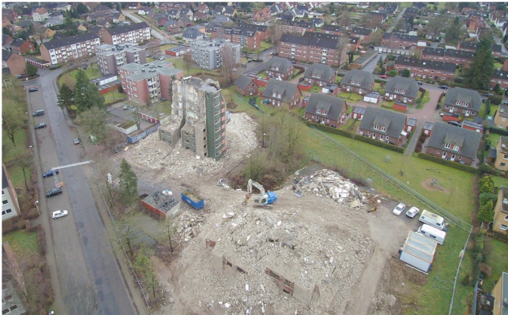
Der Rückbau der beiden Punkthochhäuser in der Danziger Straße
