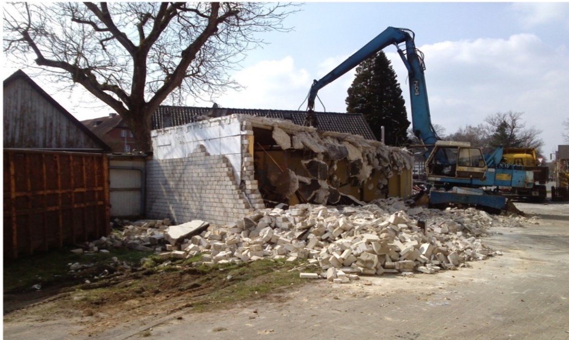
Der Rückbau der ehemaligen Spielhalle in der Kirchgasse
