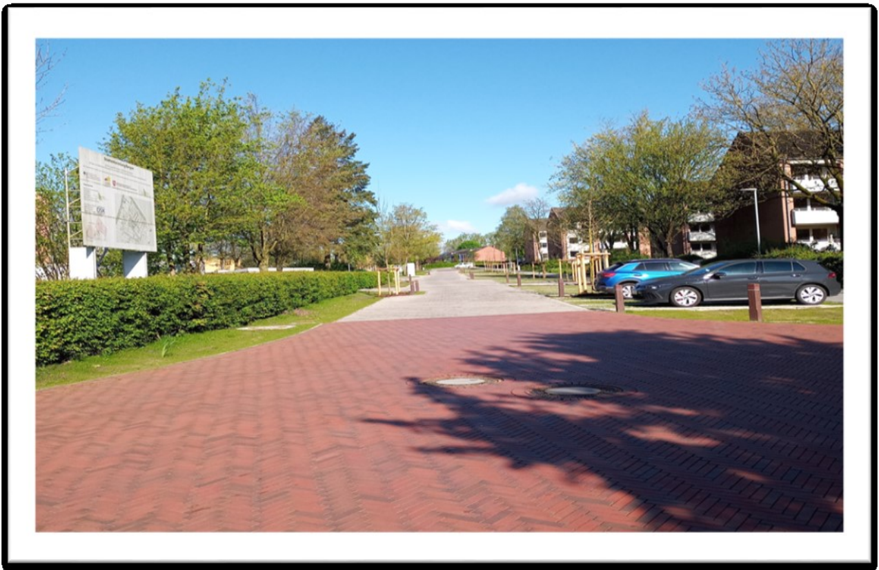
Nach der Fertigstellung der Danziger Straße (nördlicher Abschnitt)
